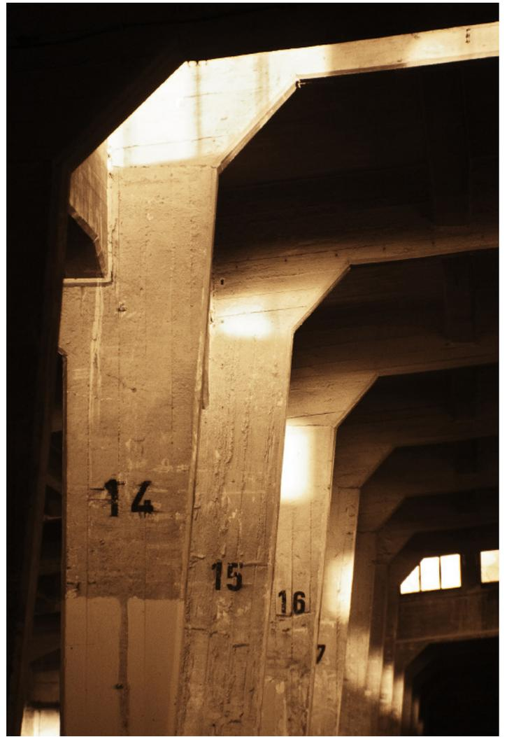
Die Reihung der nordwestlichen südlichen Mittelrahmenstützen im Schuppeninneren mit einem Abstand von 9,5 m je Joch. Rund 3.000 m<sup>2</sup> Fläche werden so weitgehend barrierefrei mit einer feuersicheren Konstruktion überdacht. Foto: Christoffer Greiß.
