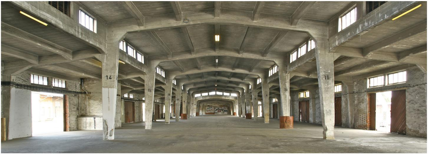
Bild oben: Die große Halle von Süden nach Norden. An einen Mittelrahmen sind jeweils zwei einhäufige Seitenrahmen angehängt. Dadurch kann das Dach gestaffelt werden und einen Lichtgaden ausbilden. Foto: Thomas Radbruch.
